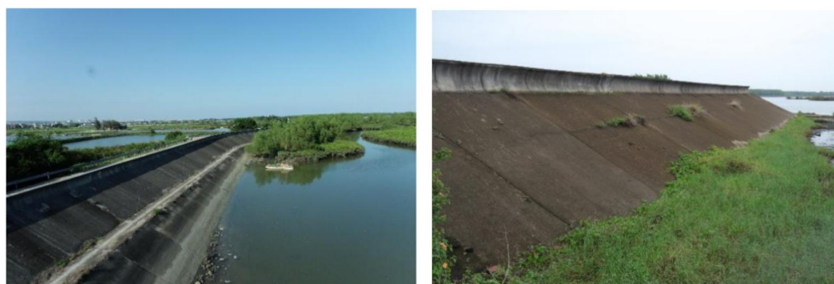
图 2.2.1-2 海堤现状照片
