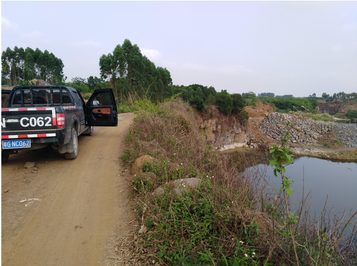
照片 2 矿坑边坡顶农耕路及崩塌
