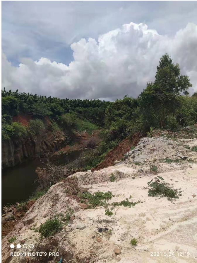
照片 5 矿坑边坡崩塌（镜头向南西）
