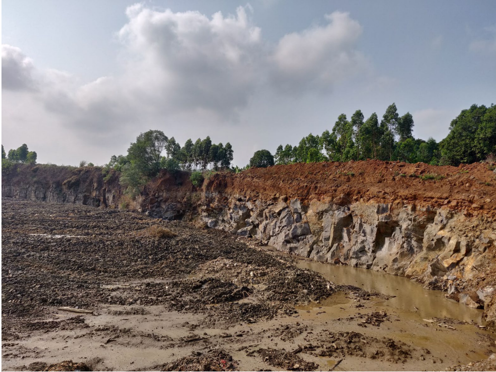
照片 3 矿坑边坡岩土特征
